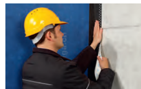
Fassadenbahn an Massivbauwand Seite 44
