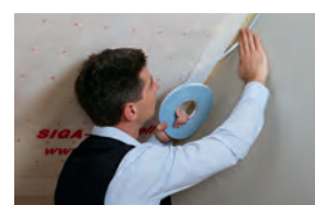
Dampfbremse an Massivbauwand
