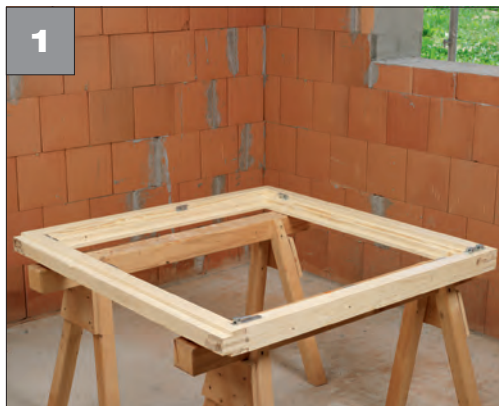
1 Ausgangssituation: • Bereitgelegter Blendrahmen
