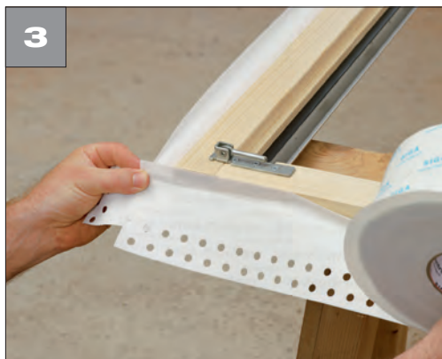
3 • Seitlich an Blendrahmen kleben • Unten ca. um Fugenbreite überstehen lassen • Gut anreiben
