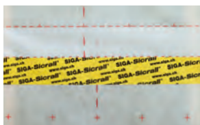
Überlappungen bei Dampfbremsen
