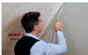
Dampfbremse an Massivbauwand Seite 32
