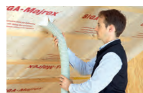
Montage Dampfbremse bei Einblas-Dämmung
