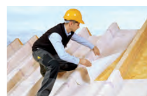
Montage Dampfbremse bei Dachsanierung von aussen
