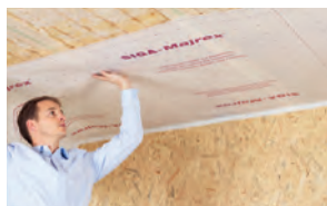
Montage Dampfbremse
