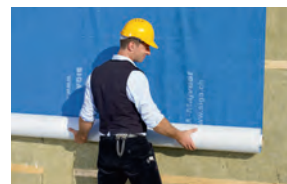
Montage Fassadenbahnen
