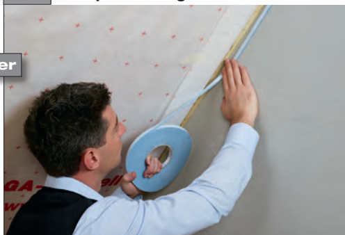
2 Nach der Dampfbrems-Montage Raupe anbringen
