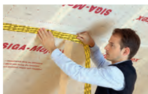
Überlappung bei Dampfbremsen
