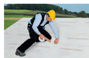
Montage Dampfbremse bei Aufsparrendämmung
