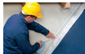
Unterdeckbahn an Massivbauwand Seite 46
