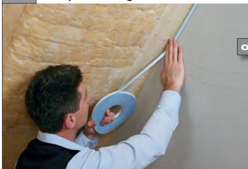
1 Vor der Dampfbrems-Montage Raupe anbringen
