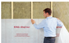
Montage Dampfbremse
