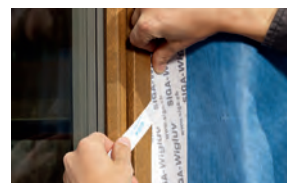
Fenster an Fassadenbahnen
