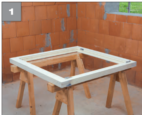
1 Ausgangssituation: • Bereitgelegter Blendrahmen
