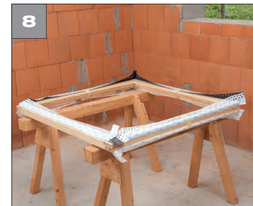
8 • Rahmen drehen • Schürze für aussen vorbereiten
