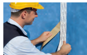
Überlappung bei Fassadenbahnen
