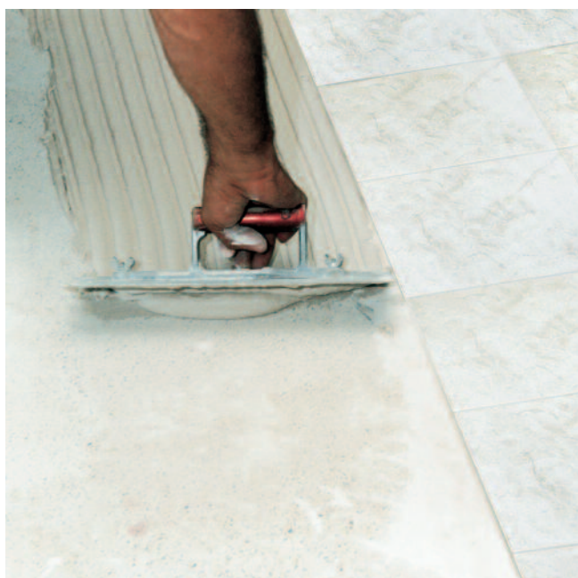
PCI Carrament ist ein plastisch-geschmeidiger Mittelbettmörtel und lässt sich leicht auftragen.
