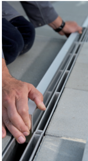
Montage der LED Elemente in den Schlitzrahmen
