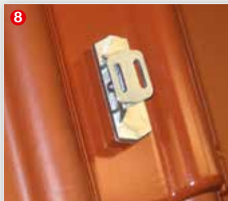
8 Das war's schon! Jetzt ist die Alu-Solar-Trägerpfanne für die unterschiedlichen Energie-Dachsysteme vorbereitet.
