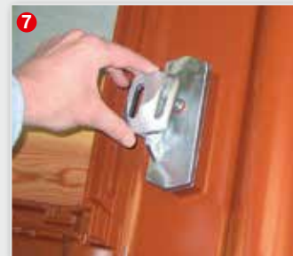
7 Anschließend den montierten Solarträgeraufsatz nach Dachneigung ausrichten.
