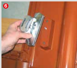
6 Jetzt kann der Solarträgeraufsatz mit der Trägerpfanne verschraubt werden.
