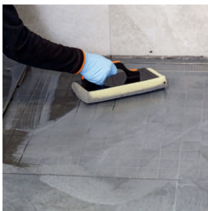
Nach ca. 10 - 45 Min. die eingefugte Fläche mit einem Schwammbrett anemulgieren und sauber abwaschen.
