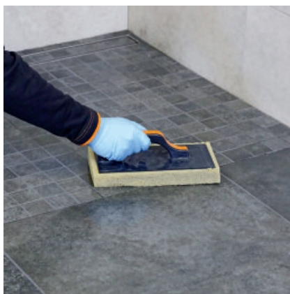
Anschließend mit dem Schwammbrett den Restschleier aufnehmen und die Fläche sauber waschen.
