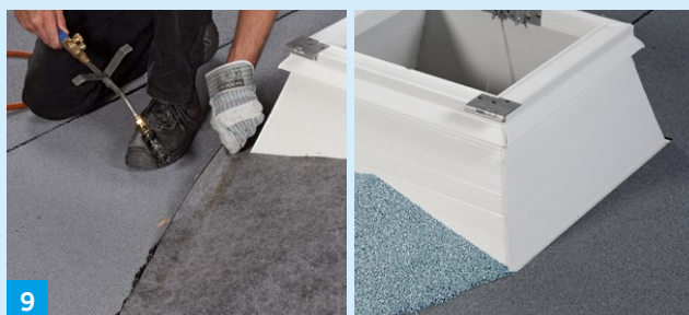
9 Villaperl ist nach ca. 1 Std. begehbar – nachfolgende Schichten müssen nach Aushärtung des Materials direkt aufgebracht werden
