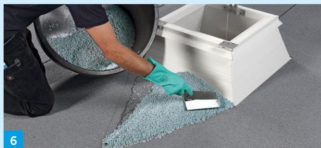
6 Villaperl auf der markierten Fläche verteilen
