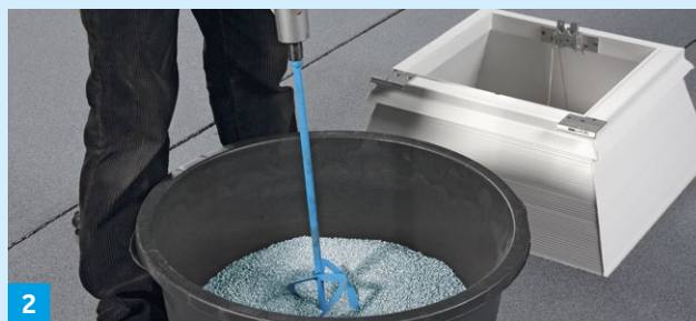
2 Mit einem langsam laufenden Rührwerk gut vermischen, Rührzeit mind. 2 Minuten
