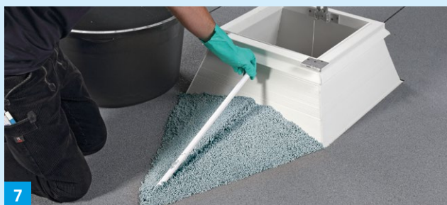
7 Richtlatte entfernen und mit Villaperl auffüllen
