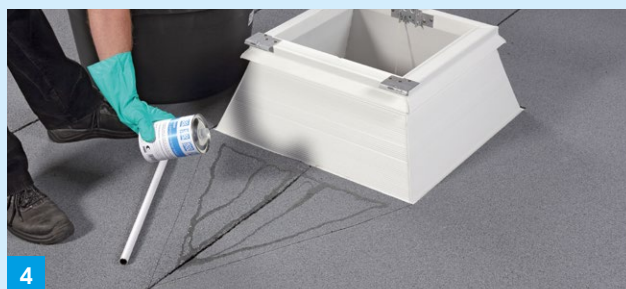
4 Ggf. Villaperl-Härter als Haftverbesserer auf dem Untergrund verteilen
