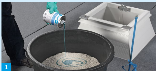
1 Villaperl-Schüttung zusammen mit dem Villaperl-Härter in einen runden 90 l Behälter füllen
