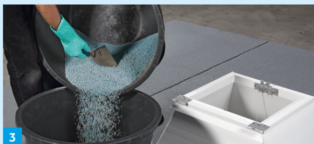
3 Wichtig: Anschließend umtopfen und nochmals mind. 1 Minute mischen, damit die Schüttung gleichmäßig mit dem Härter benetzt wird
