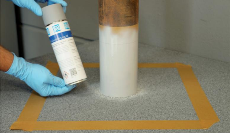
3. Rohre aus Metall mit Profi-Dicht Grundierung M besprühen
