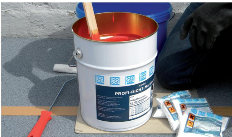
2. Profi-Dicht Markierung gut aufrühren und die benötigte Menge in ein sauberes Gefäß füllen. Nun wird die auf diese Menge und auf die Temperatur abgestimmte Menge an Katalysator zugegeben und gut untergerührt. Mischzeit mind. 2 Minuten
