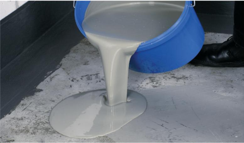
4. Profi-Dicht Fläche satt vorlegen und gleichmäßig verteilen.
