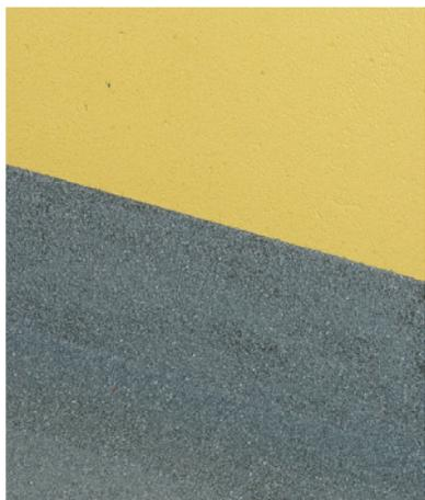
5. Abdichtenden Bereich satt mit einer Deckschicht von mind.  $1,0 \text{ kg/m}^2$  abdecken
