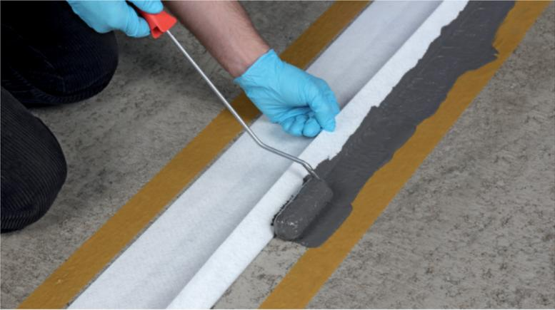
5. Nicht klebende Vlies-Streifen anheben und die verarbeitungsfertige Profi-Dicht Mischung mit einer Fellrolle satt auf den Untergrund auftragen, min.  $2,0 \text{ kg/m}^2$
