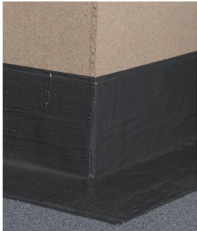
7. Abdichtenden Bereich satt mit einer Deckschicht von mind.  $1,0 \text{ kg/m}^2$  abdecken
