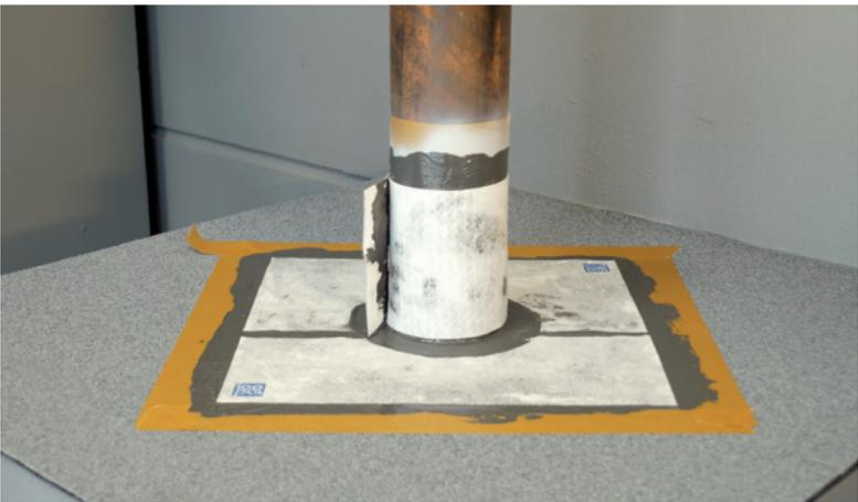
7. Anschließend Profi-Dicht Mischung an der Rohrwandung auftragen und den Zuschnitt Profi-Dicht Vlies anlegen
