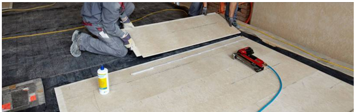
Abbildung 12: Verlegung von Rigidur Estrichelementen
