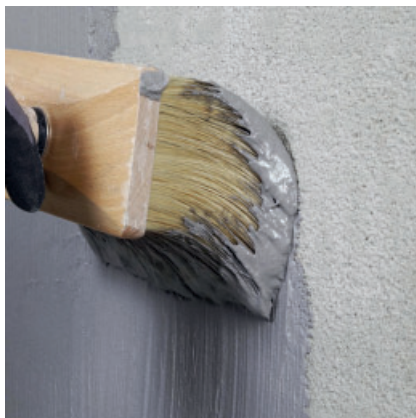
Aufbringen einer Kontaktschicht mittels Bürste oder Quast.
