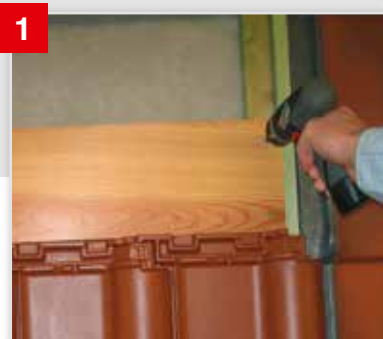
1 Holzbohle in Stärke der Traglatte (ca. 160 mm breit) direkt oberhalb der Dachziegel in die Konterlattung befestigen.
