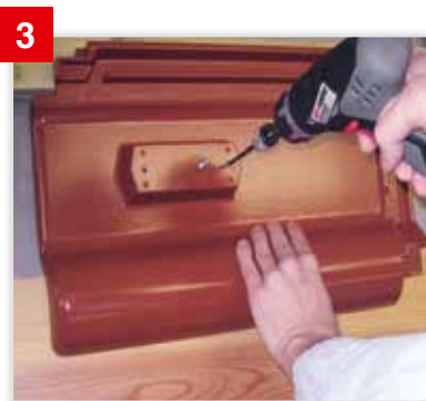
3 Die Alu-Solar-Trägerpfanne an den vorgezeichneten Stellen durchbohren \varnothing ca. 6 mm.
