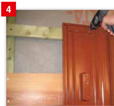
4 Die Alu-Solar-Trägerpfanne mit den beige-fügten Edelstahlschrauben an der Traglatte befestigen.
