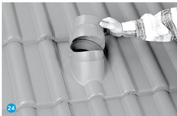
Die DuroVent Abgaskalotte ist für die Durchführung der Abgaskalotte von Gasthermen und Brennwertgeräten vorgesehen, deren Innenrohr außen nicht wärmer als +85 °C wird.
