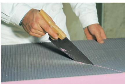
Das Zuschneiden der Uniplatte: Einfach mit dem Fuchsschwanz zurecht sägen ...
