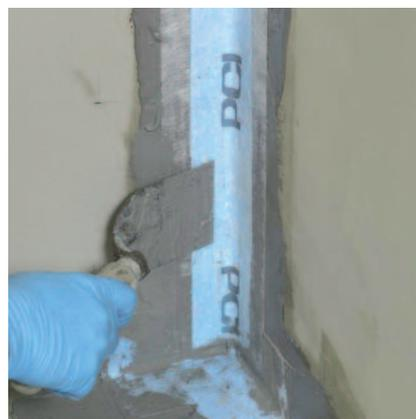
Die Dichtbänder PCI Pecitape in die Eckverbindung eindichten.
