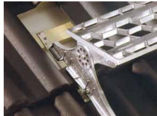
Das TopStep-Dachtrittsystem wird mit einem Edelstahlhalteband an einer zusätzlichen Montageplatte (4 x 6 cm) mit einer Holzschraube A2 (Edelstahl) 5 x 40 mm angeschraubt.
