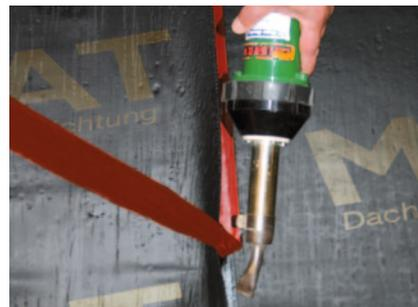
Durch Abziehen des roten Streifens und Anpressen mit einem Nahtroller wird die Naht herkömmlich „kalt verschlossen“.
