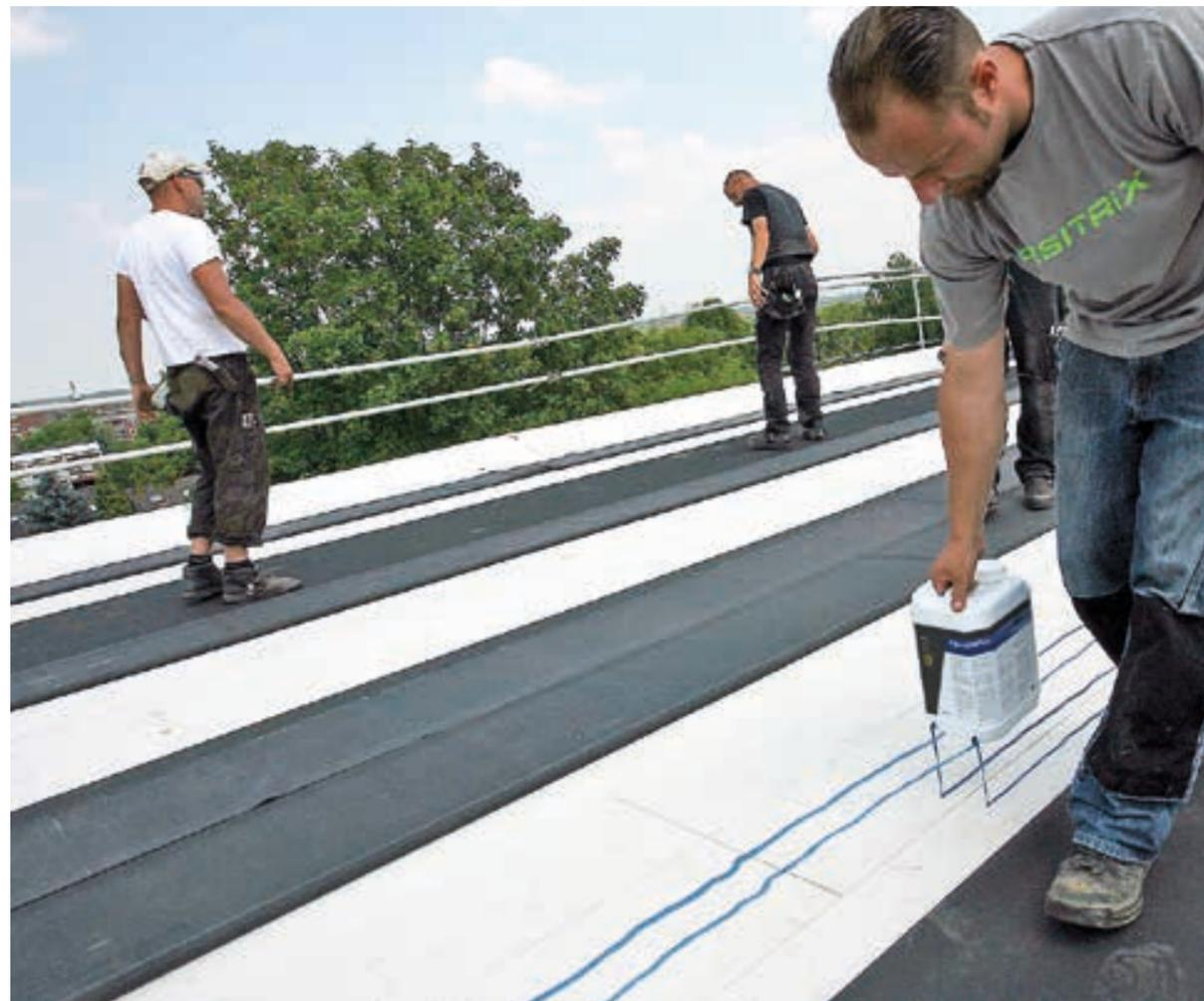
STREIFENWEISER, GRADLINIG VERLAUFENDER AUFTRAG VON PU-LMF-02 AUF DER EPS-DÄMMUNG.
