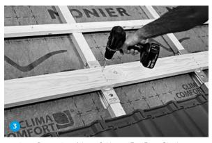
oberes Brett sichern (oberer Schlitz am EasyFix ist Oberkante Brett) und ggf. untere Traglatte durch ein Brett ersetzen.
