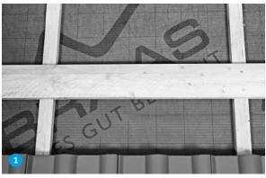
Je nach Anforderung: Obere Traglatte zusätzlich sichern oder obere Traglatte durch ein Brett in Traglattenstärke (z.B. in 120 mm Breite) ersetzen und ggf. untere Traglatte durch ein Brett ersetzen.
