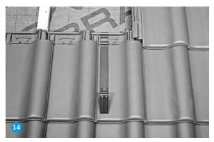
Schneestopphaken Rubin 15V nach links versetzt Richtung Wasserfalz verlegen, bei Granat 11 V auf den Mittelwulst hängen. Abbildung zeigt Rubin 15V.
