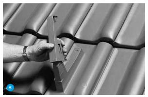
Schneefanggitterstütze aufsetzen und einrasten.
