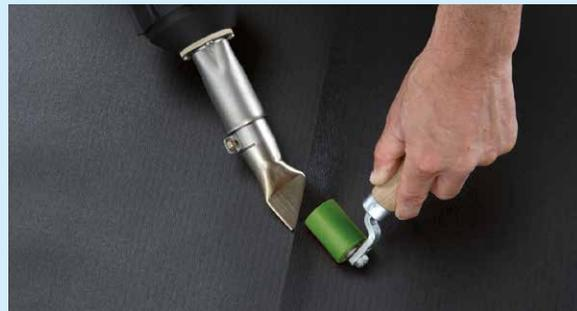
Flächennähte können mittels Heißluft (Handgerät oder Automat) verschweißt werden. Im Detailbereich wird generell mit Heißluft geschweißt, z. B. Innen- und Außenecken, T-Stöße oder Rohreinfassungen.
