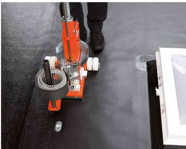
Rationelle Befestigung der BMI Drill-Tec Flachdachbefestiger mit einem professionellen Setzautomaten
