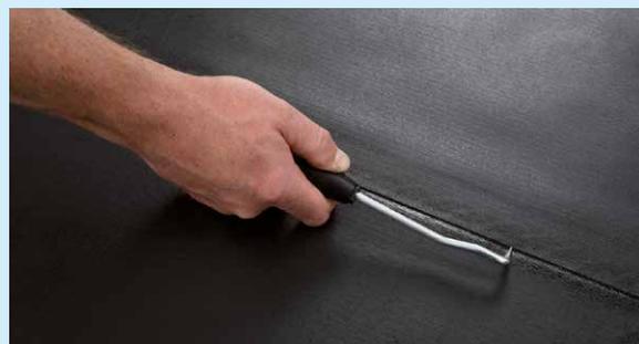
Nahtkontrolle mit Prüfnadel.
