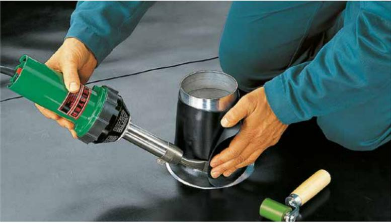
**2.** Den Flansch quadratisch/rund aus Wolfin IB zuschneiden (Abmessung min.  $\varnothing$  Rohr + ca. 250 mm) und mit einem mittigen runden Loch versehen ( $\varnothing$  Loch = Rohrdurchmesser – ca. 40 mm). Die Bahnenkante im Loch erwärmen und leicht dehnen.
