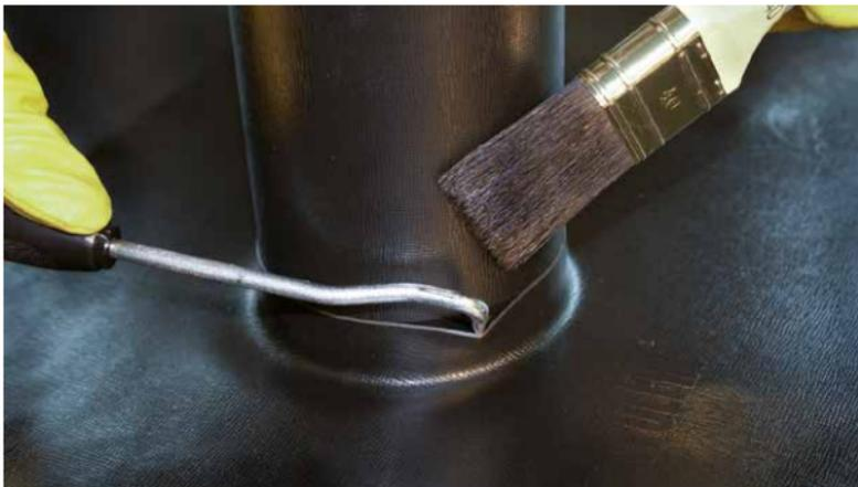
**5.** Den Flansch auf der Flächenabdichtung homogen verschweißen. Eine Fixierung der Flächenabdichtung zur Aufnahme von horizontalen Kräften ist erforderlich (siehe Pkt. 3.5). Hierzu können auch Einzelbefestiger verwendet werden.
