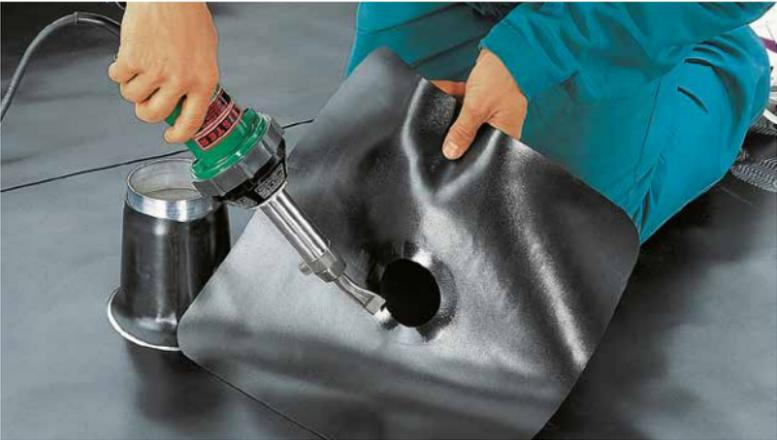
**3.** Den vorbereiteten Flansch über das Rohr und die Manschette ziehen, sodass ein ca. 20 mm hoher „Kragen“ vertikal auf die Manschette geht. Kehlpunkt von Manschette und Flansch mittels Heißluft verschweißen und anschließend gut abkühlen lassen.
