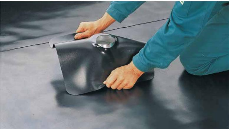
**4.** Die Manschette und den Flansch mit Quellschweißmittel verschweißen. Hierbei wird der „Kragen“ mit einer Prüfnadel leicht geöffnet, sodass das Quellschweißmittel in die Naht einlaufen kann. Diesen Bereich anschließend mit einer Silikonrolle andrücken und Quellschweißmittelreste mit einem Lappen entfernen.
