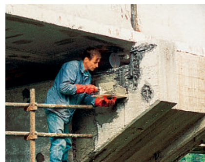
Instandsetzen einer Brücke mit Reparaturmörtel PCI Peciment 50 entsprechend den Vorschriften der ZTV-ING.
