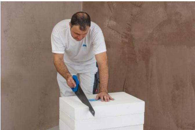
Passtücke werden einfach mit einem feinzahnigen Fuchsschwanz auf beliebige Maße zugeschnitten. Rotkalk in-Board lassen sich aufgrund ihrer geringen Dicke problemlos mit einem Cutter schneiden.
