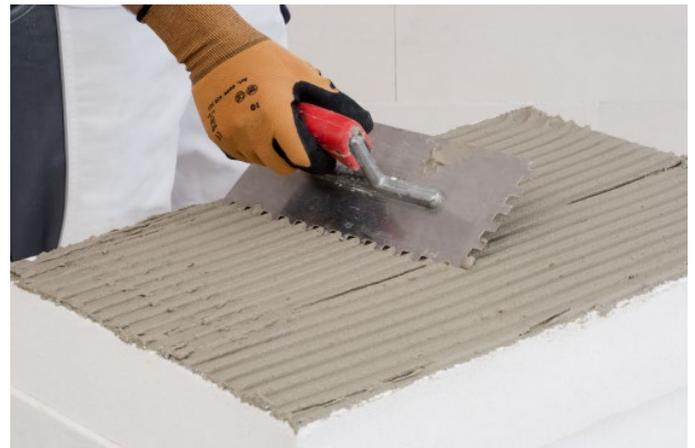
Die Verklebung von Rotkalk in-Board 045 und Rotkalk in-Board Laibung erfolgt vollflächig mit dem auf das System abgestimmten, diffusionsoffenen Rotkalk in-Klebmörtel. Der Klebemörtel wird vollflächig auf die Dämmplatten aufgetragen und mit einer Zahntraufel durchkämmt (Zahnung mind. 10 mm x 10 mm; Mindestauftragsdicke 5 mm).
