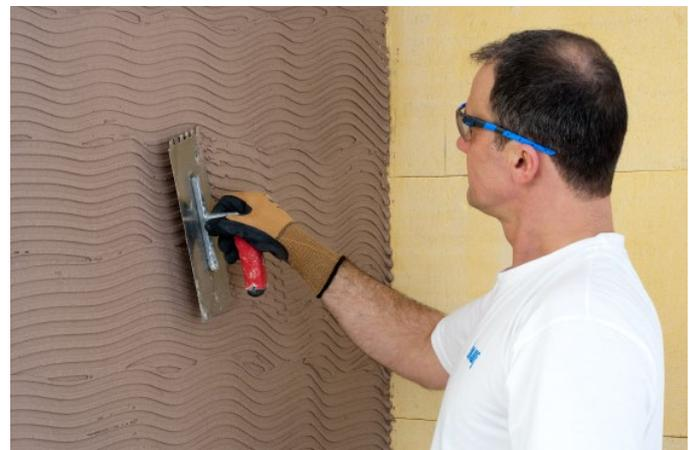
Vorhandene Fehlstellen mit Rotkalk Fein aufputzen, trocknen und erhitzen lassen. Rotkalk Fein ca. 5 mm dick auftragen, mit einer groben Zahntraufel verziehen und aufrauen. Standzeit mindestens 3 Tage.
