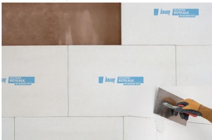
Unmittelbar nach dem vollflächigen Auftrag des Rotkalk in-Klebmörtels Dämmplatten in waagerechten Reihen unter gleichmäßigem Druck schiebend andrücken und lot- sowie fluchtgerecht ausrichten.
