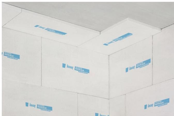
Zur Vermeidung der Wärmebrückenwirkung wird die Laibungsplatte als flankierende Dämmung an einbindende Innenwände und Decken eingebaut. Aus optischen Gründen kann die Stirnseite nach dem Verlegen mit dem Schleifbrett angeschrägt werden.
