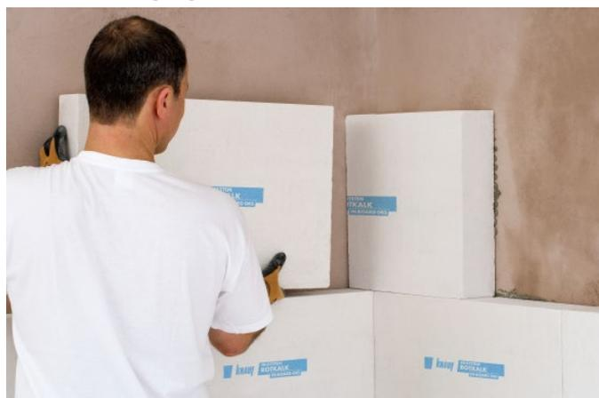
In Eckbereichen ist Rotkalk in-Board 045 zu verzahnen. Abschneiden der überstehenden Dämmplatten an Außenecken, erst nach Abbinden des Klebers.
