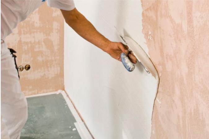
Oberputz Rotkalk Filz / Rotkalk Struktur / Rotkalk Glätte / Rotkalk Fein in der erforderlichen Schichtdicke auftragen und gemäß jeweiligem Technischen Blatt bearbeiten.
