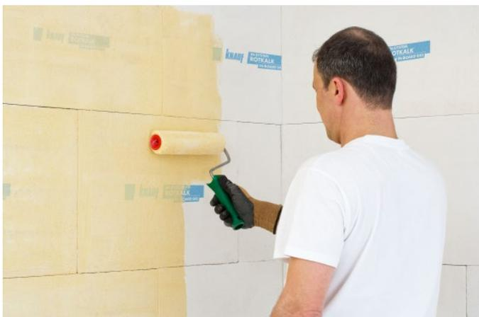
Zur Haftverbesserung der Oberflächenbeschichtung wird die gesamte Fläche mit Grundierung vorbehandelt. Knauf Aufbrennsperre mit Wasser im Verhältnis 1:3 verdünnen und durch Spritzen oder Rollen vollflächig und gleichmäßig auf Dämmplatten auftragen.
