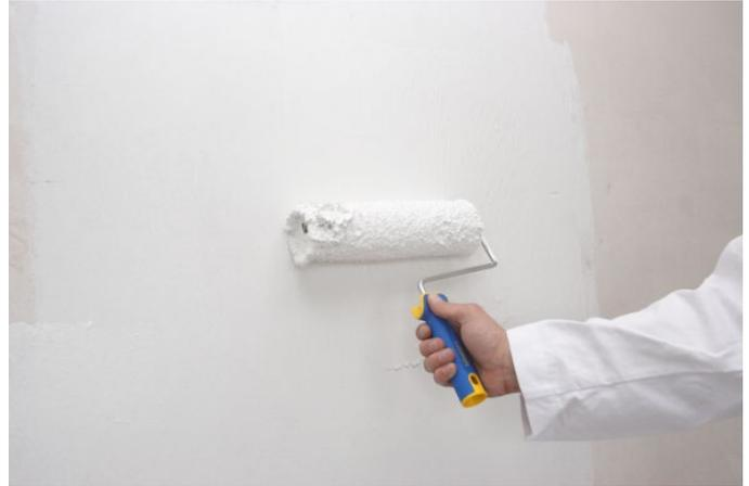
Als Schlussbeschichtung kann zusätzlich ein Farbanstrich aus diffusionsoffener Silikat-, Kalk- oder Kreidefarbe, vorzugsweise Rotkalk Farbe, aufgebracht werden.
