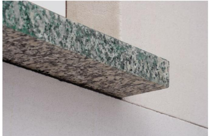
Fugendichtband FD entsprechend der Fugendimensionierung in die Anschlussbereiche einpassen.
