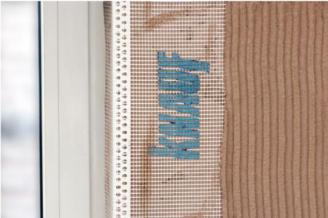
Fensteranschlussprofil auf die notwendige Länge zuschneiden und entsprechend der Laibungsplattendicke auf den sauberen Fenster- oder Türrahmen aufkleben und fest andrücken. Das an dem Anputzprofil (z. B. Knauf Fensteranschlussprofil Standard) befestigte Gewebe wird später in die Armierungsschicht eingebettet. Dabei eine Gewebeüberlappung von mind. 10 cm einhalten.
