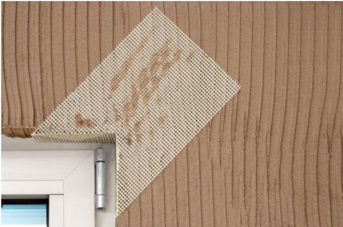
In den Eckbereichen von Fenster- und Türöffnungen Gewebeeckpfeile im Nassmörtel einbetten. In der Innenecke Sturz/Laibung sind zusätzlich Gewebestreifen erforderlich.
