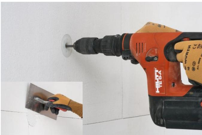
Die Verdübelung erfolgt nach Aushärtung des Rotkalk in-Klebmörtels. Erforderliche Dübelanzahl: 1 Dübel pro Platte. Dübel oberflächenbündig oder versenkt montieren. Zum Verschließen können STR U 2G Stopfen bzw. STR U 2G Rondellen verwendet werden.
