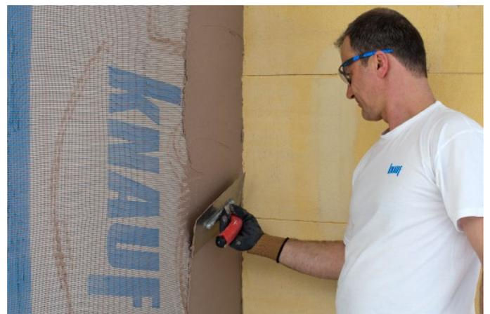
Armiergewebe vollflächig, an den Stößen mindestens 100 mm überlappend, nass in nass im äußeren Drittel der Armierschicht einbetten. Die blauen Randstreifen dienen hierbei als Überlappungsmarkierung. Das Gewebe muss vollständig überdeckt sein.
