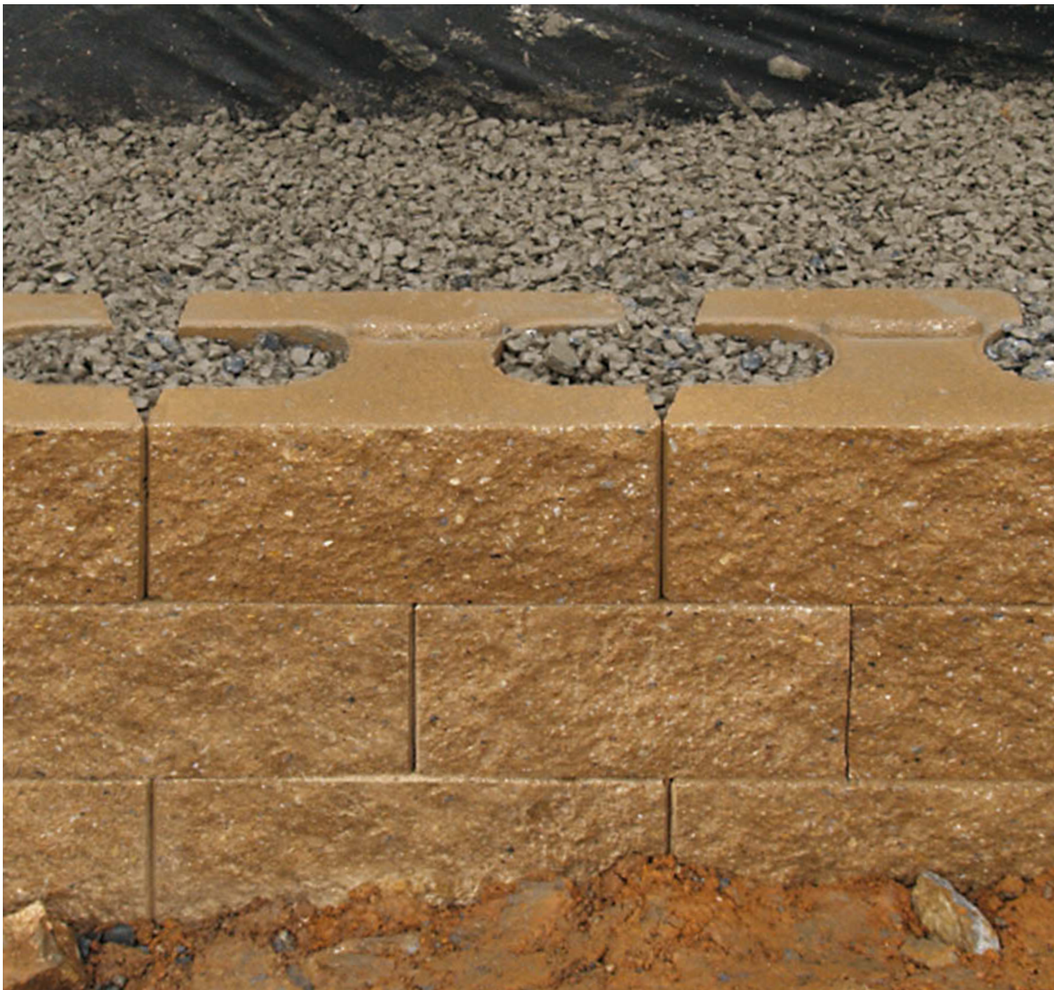
Produkt: Vertica® Mauer Format: 45 x 28 x 20 cm (Normalstein)
