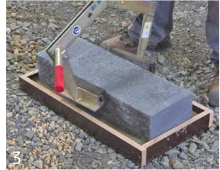
3 Nun wird der Mauerstein eingetaucht, danach muss die Unterseite vollflächig mit Haftschlämme benetzt sein.
