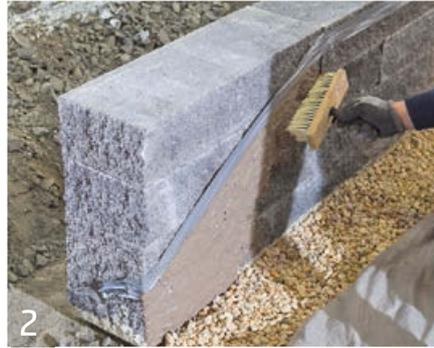
2 ... mit einer Abdichtung versehen. Die vertikale Sperrschicht kann – wie hier dargestellt – z. B. mit einem Quast aufgetragen werden. Die Art der Verarbeitung ist jedoch dem verwendeten Material geschuldet.
