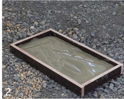
2 Eine Haftbrücke wird gemäß den Herstellerangaben vorbereitet und in ein flaches Behältnis gefüllt.
