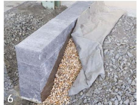
6 Die Führung für das Geotextil muss nach dem Einbringen einer Lage entfernt und neu an- gesetzt werden. Das Geotextil wird nach dem Einbringen der obersten Lage über die Filter- schicht umgeschlagen und ...
