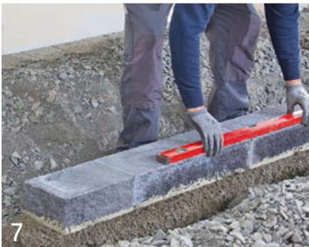
7 Nach Fertigstellung der ersten Reihe wird nochmals in Längs- und Querrichtung gefluchtet und ausgerichtet.
