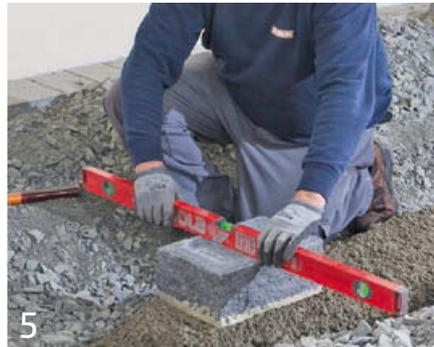
5 Anschließend richtet man den Stein in Längs- und Querrichtung aus und kontrolliert die Höhenlage.
