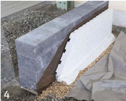
4 ... die zwischen der abgedichteten Mauer und der Drainageschicht angeordnet wird. Der unterste Punkt der Drainageplatte ist auf die Oberkante des Betonfundamentes zu setzen, um eine Wasserführung bis zum Mauerfuß zu gewährleisten.
