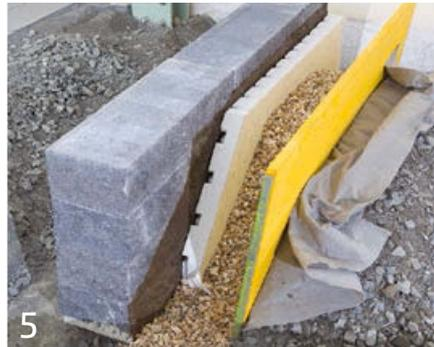
5 Nach dem Fixieren der Drainageplatte kann lagenweise verfüllt werden. Hierbei ist die Filter- oder Drainageschicht durch ein Geotextil von der Wiederverfüllung zu trennen um ein Einspülen von Feinanteilen zu verhindern. Um das Geotextil besser führen zu können, sollte es durch eine Schlatte oder Ähnliches geführt werden.
