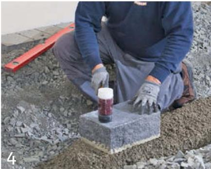
4 „Frisch in Frisch“ wird der erste Mauerstein höhen- und fluchtgerecht gesetzt und hammerfest angeschlagen.
