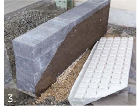
3 Nachdem die Abdichtung ausgehärtet ist, wird das Drainagesystem verbaut. Hierfür wird eine Drainageplatte verwendet, ...
