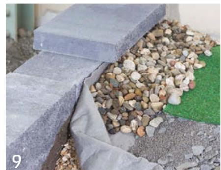
9 ... die Abdecksteine gesetzt werden (siehe Auf- bauanleitung freistehend). Die erdhinterfüllte Mauer ist fachgerecht hergestellt.
