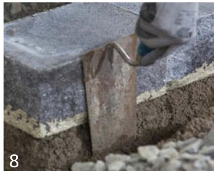
8 fläche hin abgestochen werden, um einen gleichmäßigen Aufbau des Unterbaus zu gewährleisten. Sollen die angrenzenden Flächen beidseits der freistehenden Mauer unbefestigt hergestellt werden, ist auf beiden Seiten eine Rückenstütze herzustellen. Selbiges gilt für den Arbeitsschritt „abstechen“, wenn beidseits befestigt werden soll.
