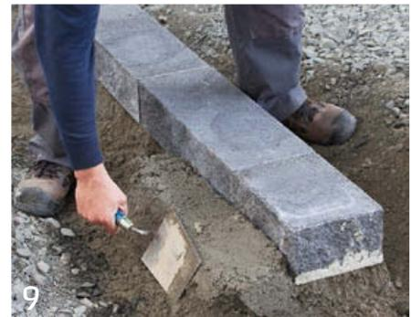
9 Zur unbefestigten Fläche hin ist eine Rückenstütze anzulegen. Diese sollte min. 10 cm breit sein und den Stein zu einem Drittel einbinden. Sie ist mit Gefälle weg vom Bauwerk anzulegen, um eindringendes Wasser zur Drainageschicht hin abzuführen. Soll die Mauer mit Drainbeton hinterfüllt werden, ist die Rückenstütze der Stärke der Drainbetonschicht entsprechend zu wählen.
