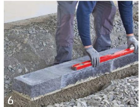
6 Als Nächstes legt man den zweiten Stein an, der ebenfalls hammerfest angeschlagen und ausgerichtet wird. Auch hier erfolgt eine Kontrolle der Flucht mittels Richtlatte oder Schnur.
