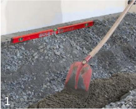
1 Das Fundament aus Beton C 20 / 25 wird erdfeucht in ca. 20 cm Stärke höhen- und fluchtgerecht eingebracht.
