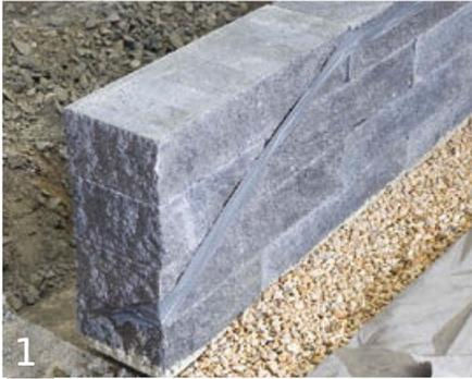
1 Führen Sie zunächst die Aufbausritte 1–11 der Catania Mauer freistehend durch, S. 162/163. Nachdem die Mauer bis zur obersten Schicht fertiggestellt wurde, wird der spätere Gelände-verlauf mit einer Zugabe von 50 mm abge- klebt und ...
