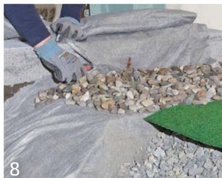
8 Jetzt muss nur noch das Geotextil abgeschnitten oder umgeschlagen werden und ...
